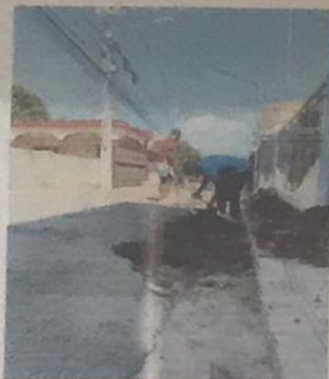
Inician los trabajos este 11 de septiembre del 2023 gracias a la colaboración de la ING Teresita Fereiras y al ING Juan Martinez en la entrada de Los Castillo
