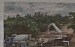
Avances del Puente Cajón
